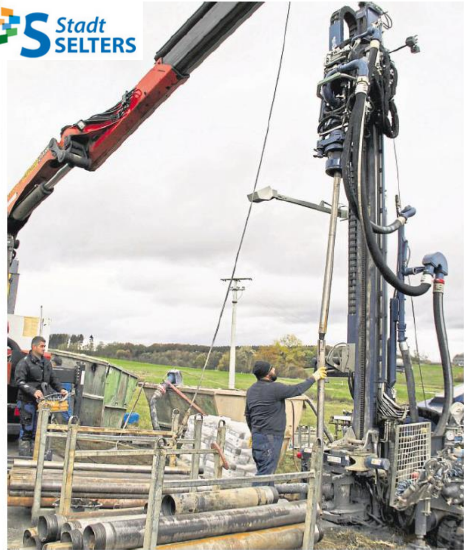
Kenan Efe (links) steuert das Bohrgerät. Es frisst sich Hunderte Meter in die Tiefe. Der Bohrkern wird probiert, um ein geologisches Profil anzulegen, in das Loch wird dann eine Probesonde gebracht, die die geothermische Leistungsfähigkeit des Untergrundes testet.
